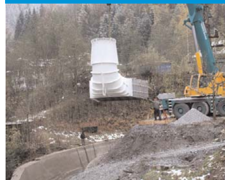
Der Grobrechen (geliefert von GMT) vor der Maschine dient in erster Linie als Mannschutz. (ganz oben) Die notwendigen Bewehrungen im Rahmen der Betonarbeiten für den Saugrohreinbau. (oben) Das Saugrohr wurde in Einzelteilen angeliefert, vor Ort verschweißt und schließlich eingehoben. (unten)
