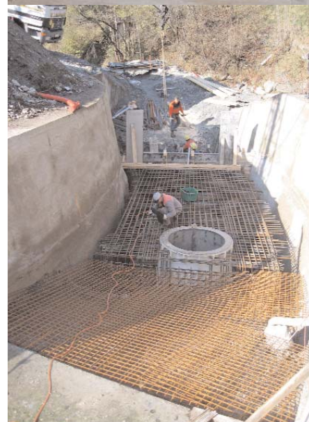
Der Grobrechen (geliefert von GMT) vor der Maschine dient in erster Linie als Mannschutz. (ganz oben) Die notwendigen Bewehrungen im Rahmen der Betonarbeiten für den Saugrohreinbau. (oben) Das Saugrohr wurde in Einzelteilen angeliefert, vor Ort verschweißt und schließlich eingehoben. (unten)
