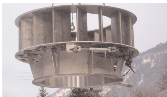
Die modulare Bauweise der Maschine trägt auch wesentlich zu einer kostengünstigen Errichtung bei. Im Bild oben: das Einheben des Leitapparats. Rechts: Die DIVE-Turbine: Laufrad und Generator sind zu einer kompakten Einheit verschmolzen.
